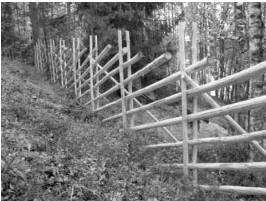
Kuvan aita on nykyaikainen versio riukuaidasta. Vitjaksien sijaan siinä on käytetty kolmen ja neljän tuuman nauvoja.
